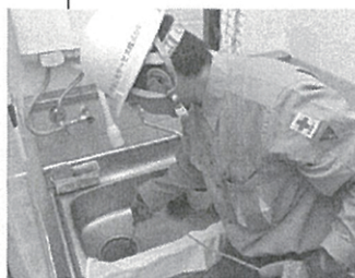
台所シンクの排水管洗浄作業
